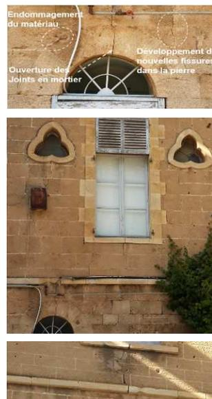
Figure 2 : Emplacement des fractures actives
